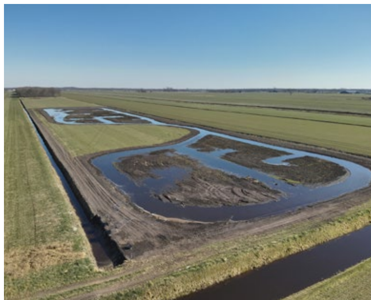
Plas-dras net na de aanleg
