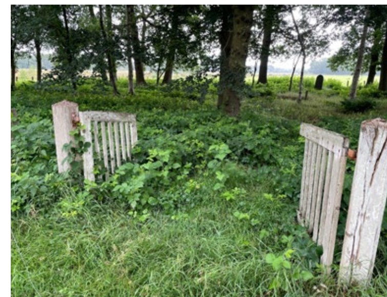
Toegangshek voor en na de herstelwerkzaamheden.
