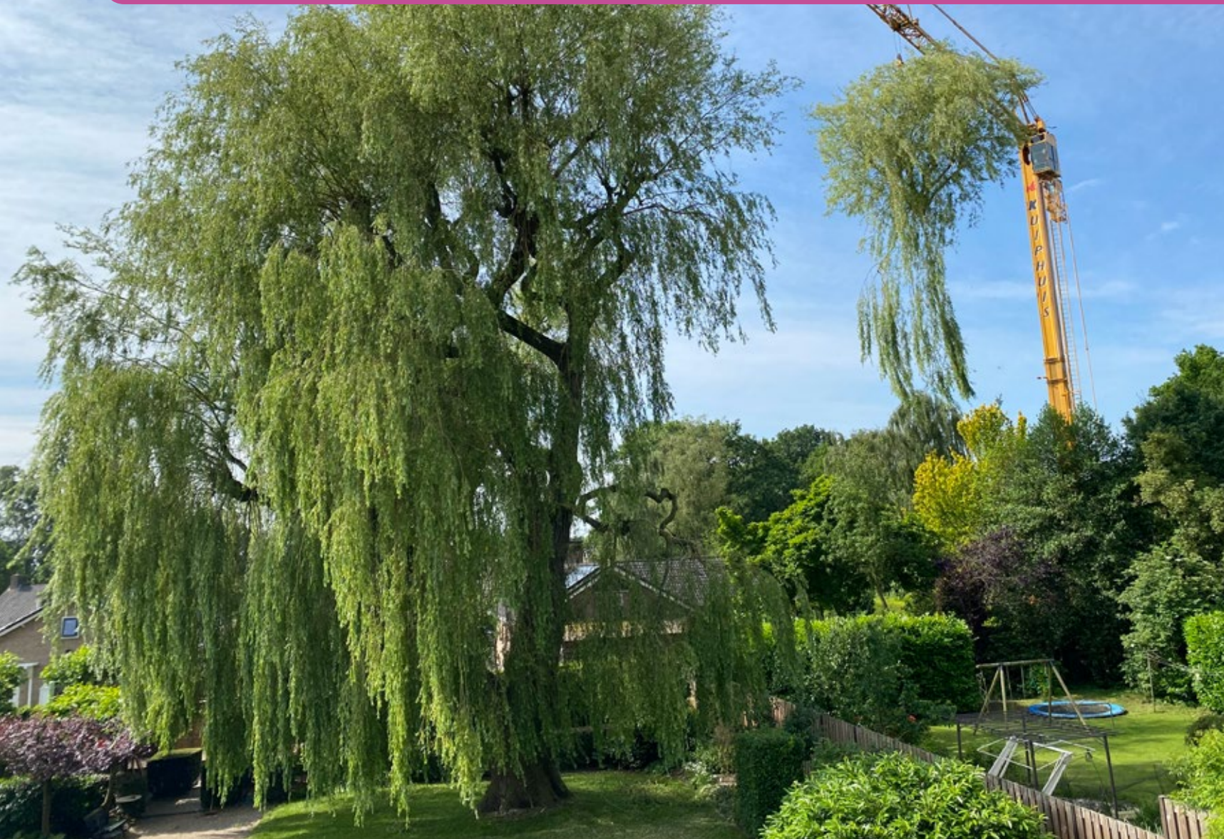
Met chirurgische precisie en met behulp van een bouwkraan werd de zieke treurwilg veilig uit de woonwijk verwijderd.
