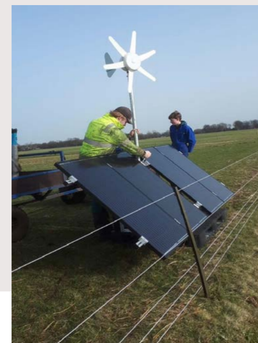
Installatie plasdraspomp en raster.
