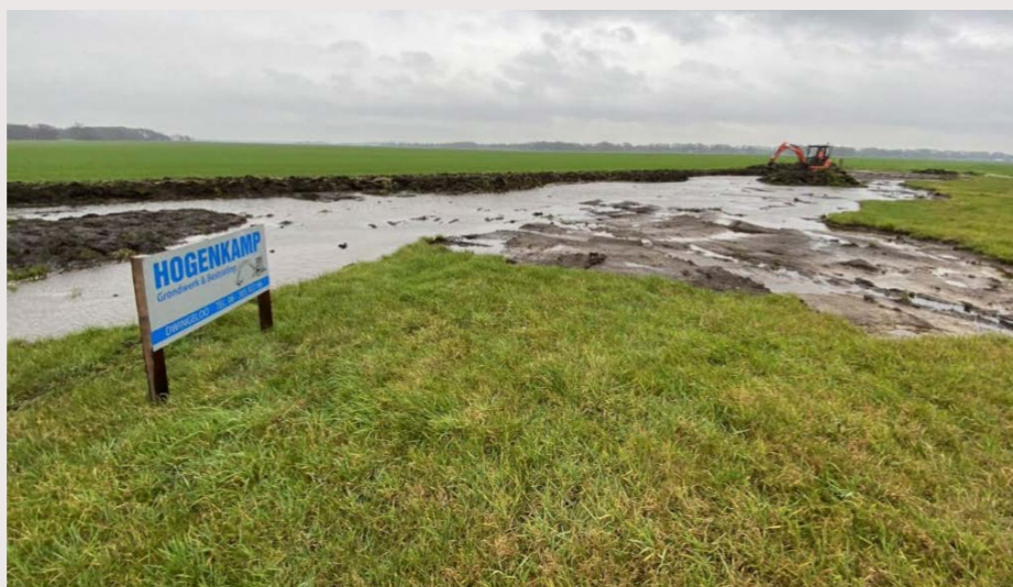
Aanleg van een plasdras.
